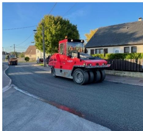
Toutes les rues du lotissement ont été réenduites en fin d'année afin de les étanchéifier et d'éviter ainsi qu'elles ne se détériorent davantage. Il reste encore à réaliser le marquage au sol qui matérialisera la zone 30 km/h à l'intérieur du lotissement. Travaux prévus au printemps.
