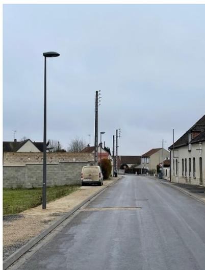
Les travaux d'enfouissement des lignes électriques et téléphoniques sont à présent terminés. Des nouveaux candélabres équipés d'éclairage leds ont été installés.
